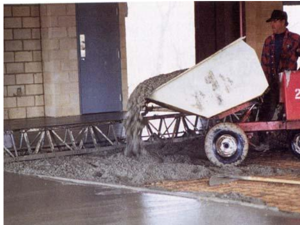
شکل ۳ روش صحیح ریختن بتن
