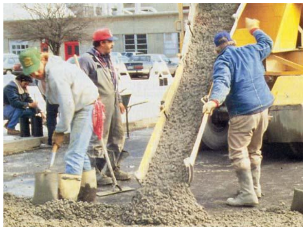
شکل ۴ انتقال بتن با استفاده از سطح شیبدار
