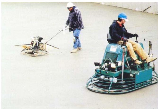
شکل ۶ پرداخت نهایی با ابزار مکانیکی
