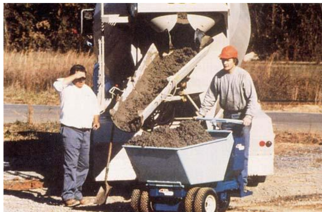
شکل ۲ انتقال بتن با استفاده از فرغون موتوری
