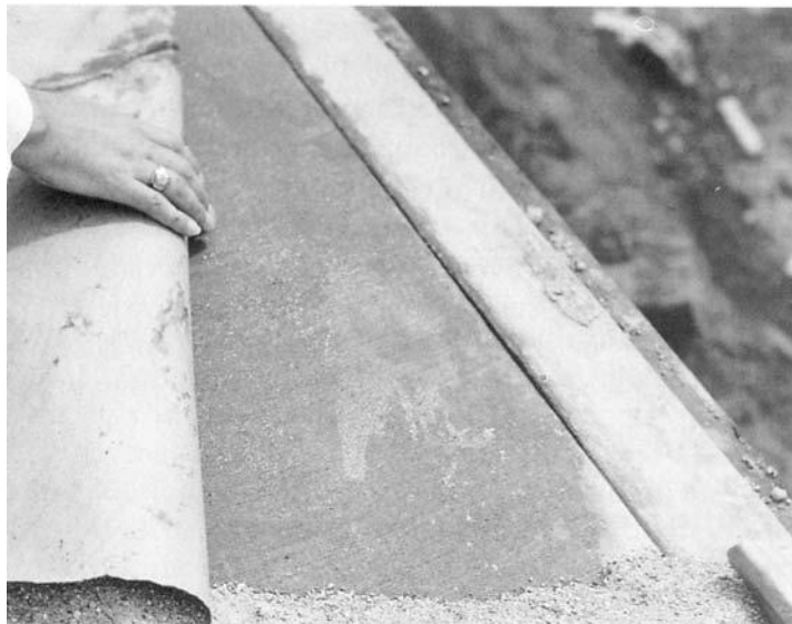
شکل ۳ عمل آوری عایقی (پوشش‌های مرکب)
