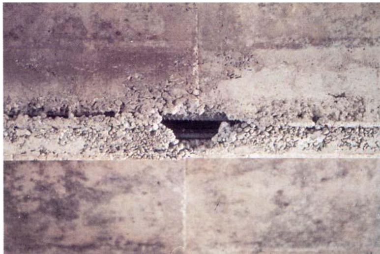
شکل ۸ نمونه‌ای از نحوه نامناسب تراکم بتن
