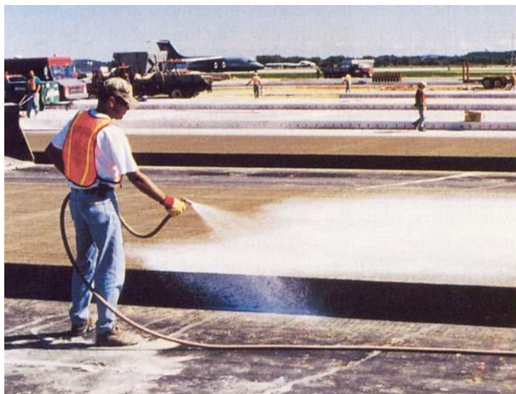
شکل ۴ روش عمل‌آوری با ماده شیمیایی غشایی
