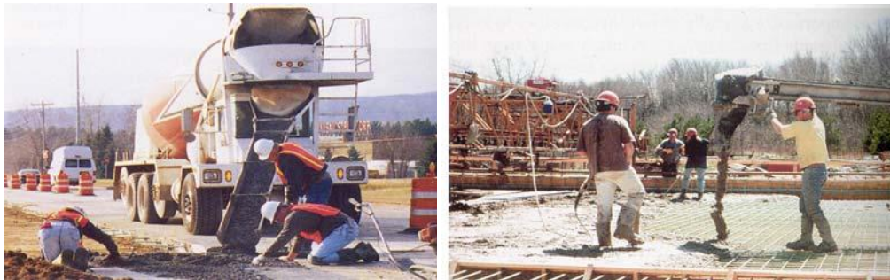
شکل ۲ ریختن بتن در نزدیکی محل مورد نیاز
