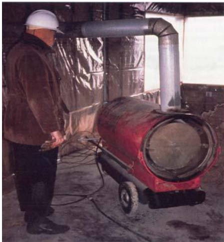
شکل ۶ یک نمونه از دستگاه‌های ایجاد حرارت برای عمل‌آوری حرارتی بتن
