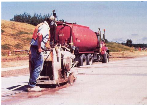
شکل ۱ استفاده از دستگاه برش برای ایجاد درز
